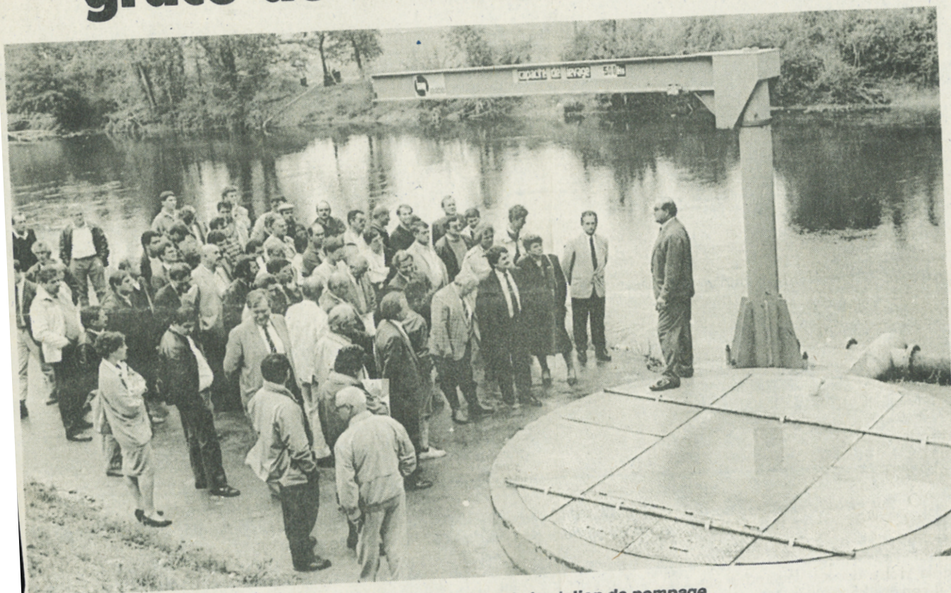
Cérémonie Inaugurale près de la station de pompage.
